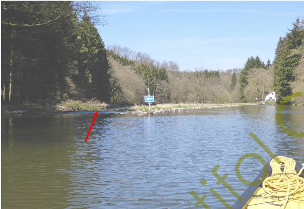
De dam van de Nawés (Moulin Deleau): een ogenschijnlijk onschuldige doorgang waar het risico op schade aan de boot reëel is. De doorgang is niet aangepast voor kano's of kajaks (aanwezigheid van metaal).
