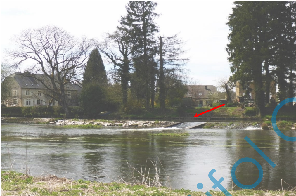
Le barrage de Lacuisine, à franchir par la belle passe aménagée au milieu (courant de rappel possible).
