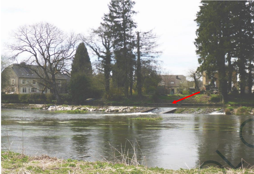
Le barrage de Lacuisine, à franchir par la belle passe aménagée au milieu (courant de rappel possible).
