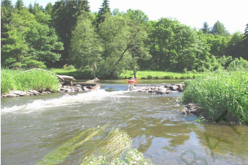
La passe du barrage de Chiny (Moulin Cambier), premier passage « mouillant » de ce parcours.
