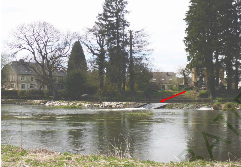
Le barrage de Lacuisine, à franchir par la belle passe aménagée au milieu (courant de rappel possible).
